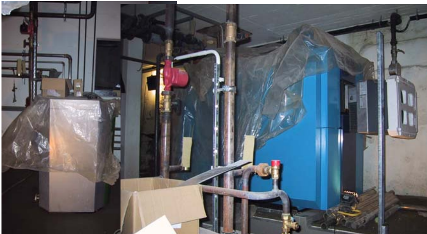
Abb. 16 Pelletkessel, Gas-Spitzenkessel und 8 m 3 Schichtenspeicher
