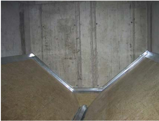
Abb. 15 Der Pellet-Lagerraum mit Schüttboden und Einblasstutzen
