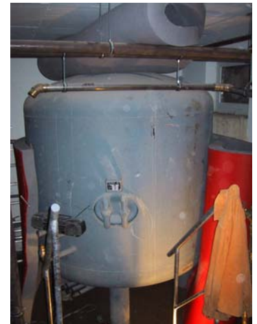
Abb. 16 Pelletkessel, Gas-Spitzenkessel und 8 m 3 Schichtenspeicher
